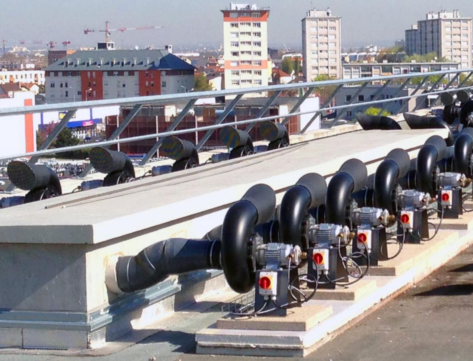
Ventilatoren aus Polypropylen für den Einsatz in aggressiven Umfeldern, z. B. in Laboren oder in der pharmazeutischen und chemischen Industrie.
